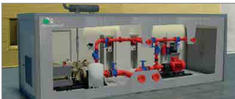
Esempio di gruppo antincendio installato
