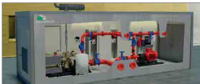
Esempio di gruppo antincendio installato
