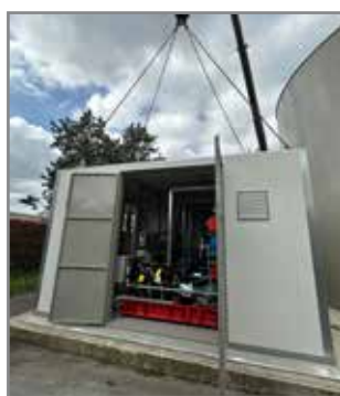
Impianto antincendio con serbatoio da interno e locale tecnico da esterno, con pompe centrifughe orizzontali
